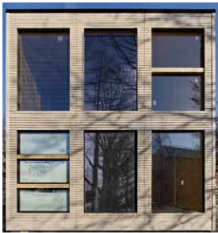
Das Prüfstandsgebäude auf dem Campus der Uni Stuttgart.
